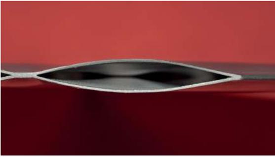
Die charakteristische Kissenstruktur ermöglicht eine starke Verwirbelung des Wärmeträgermediums und führt zu einer hohen Wärmedurchgangszahl  $k$ .
